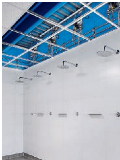
Die „AquaVip-Duscheinheit elektronisch“ unterstützt in Duschanlagen in Freizeiteinrichtungen, in Wellness- und Spabereichen von Hotelbetrieben, in Industrieunternehmen oder Sportstätten den bestimmungsgemäßen Betrieb.
