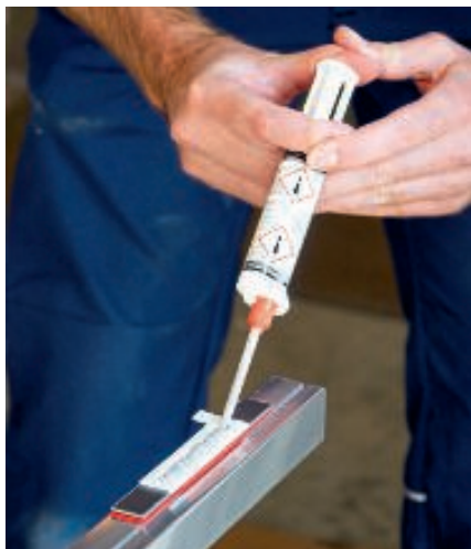
Der Kleber wird mithilfe einer Schablone gleichmäßig auf dem Wandanschlussprofil aufgetragen.
