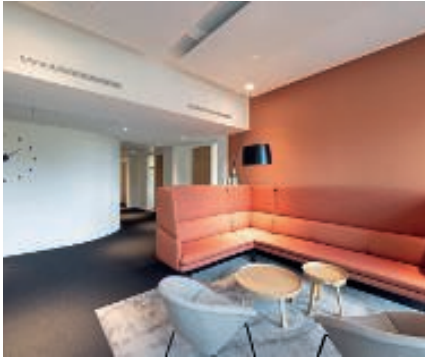
Im Bürogebäude der Schiffszimmerer-Genossenschaft strömt die Zuluft über dezente Lüftungsschlitze in den Raum, dank Smart-Boxen bedarfsgerecht und individuell.
