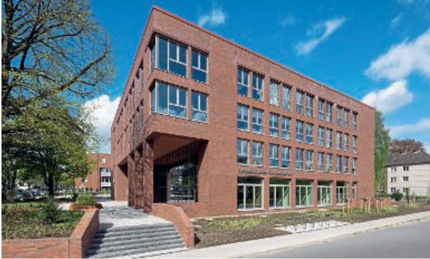
Tradition trifft auf Innovation im neuen Verwaltungsgebäude der Schiffszimmerer-Genossenschaft. Hier vereinen sich hanseatische Gestaltungswelten mit hochmoderner Technik.
