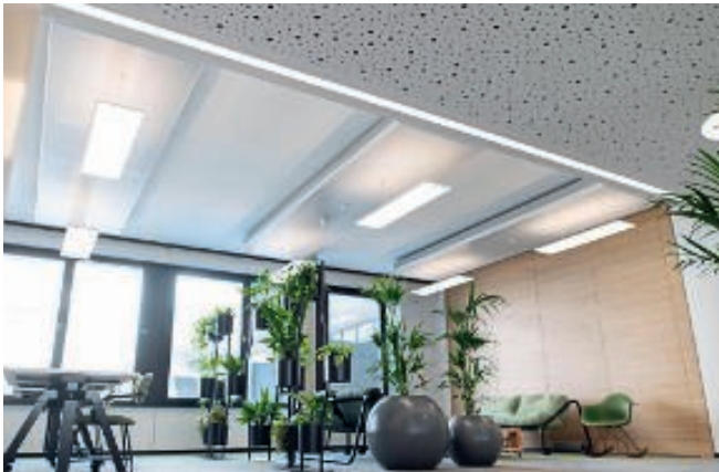
Die Heiz- und Kühlsegel Smartline heizen im Winter und kühlen im Sommer – geräuschlos und ohne Zugluft.
